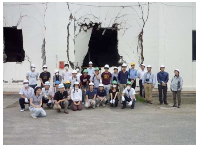
参加者の集合写真（南蒲生浄化センターの津波被災建物の前にて）
