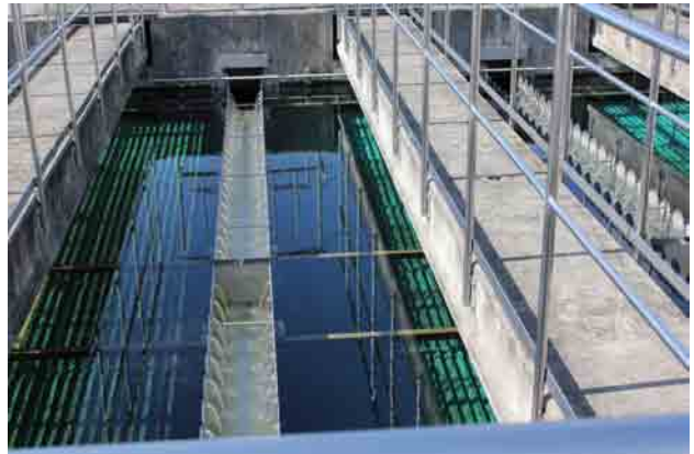
浄水場見学（傾斜板沈殿池）
